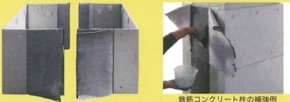
鉄筋コンクリート柱の補強例
