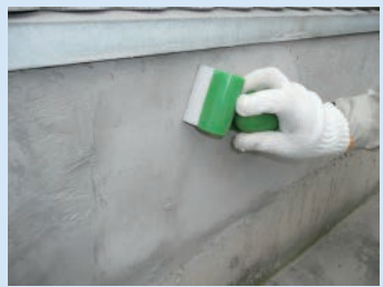
5. ドクター-Qリペアーが硬化後、スクレーパー等で削り取り、サンドペーパーで表面を仕上げる。
