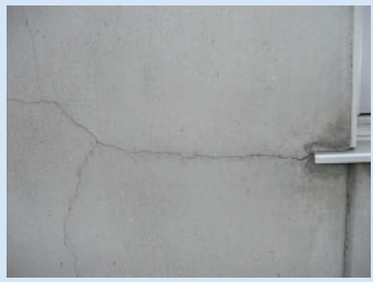
1. 補修箇所の確認
