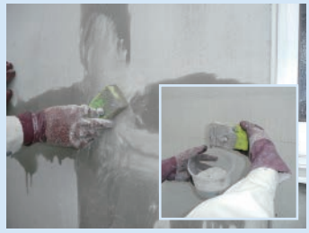
4. ドクター-Qリペアーの粉末を水分を含ませたスポンジ等を使用し、補修面に練り込むようにすり付ける(すり込み式)。
