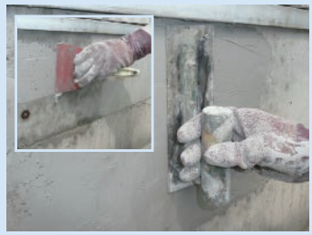
または、水練りしたドクター-Qリペアーをゴムベラ、金ゴテ、刷毛等で塗り付ける(水練り式)。
