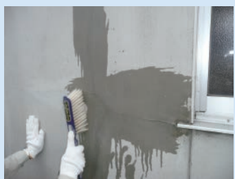
3. 補修部の周辺に十分水湿しを行う。
