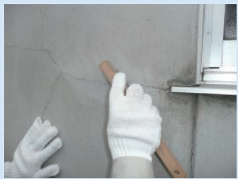
2. クラック・ピンホール補修面をワイヤーブラシ等でケレン清掃する。
