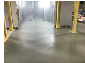
ドクター1 エース塗付け完了
